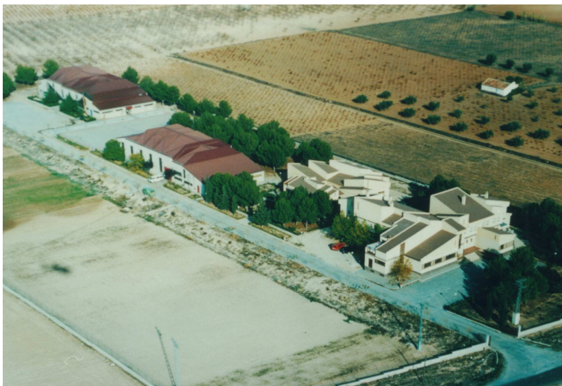
Complejo en el que se ubican la Residencia de Adultos, el Centro Ocupacional, los Pretalleres y la Piscina Climatizada.
